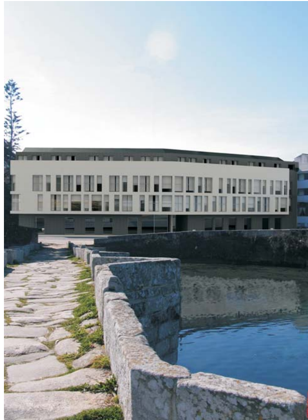
Fotocomposicion Edificio en Ramallosa
