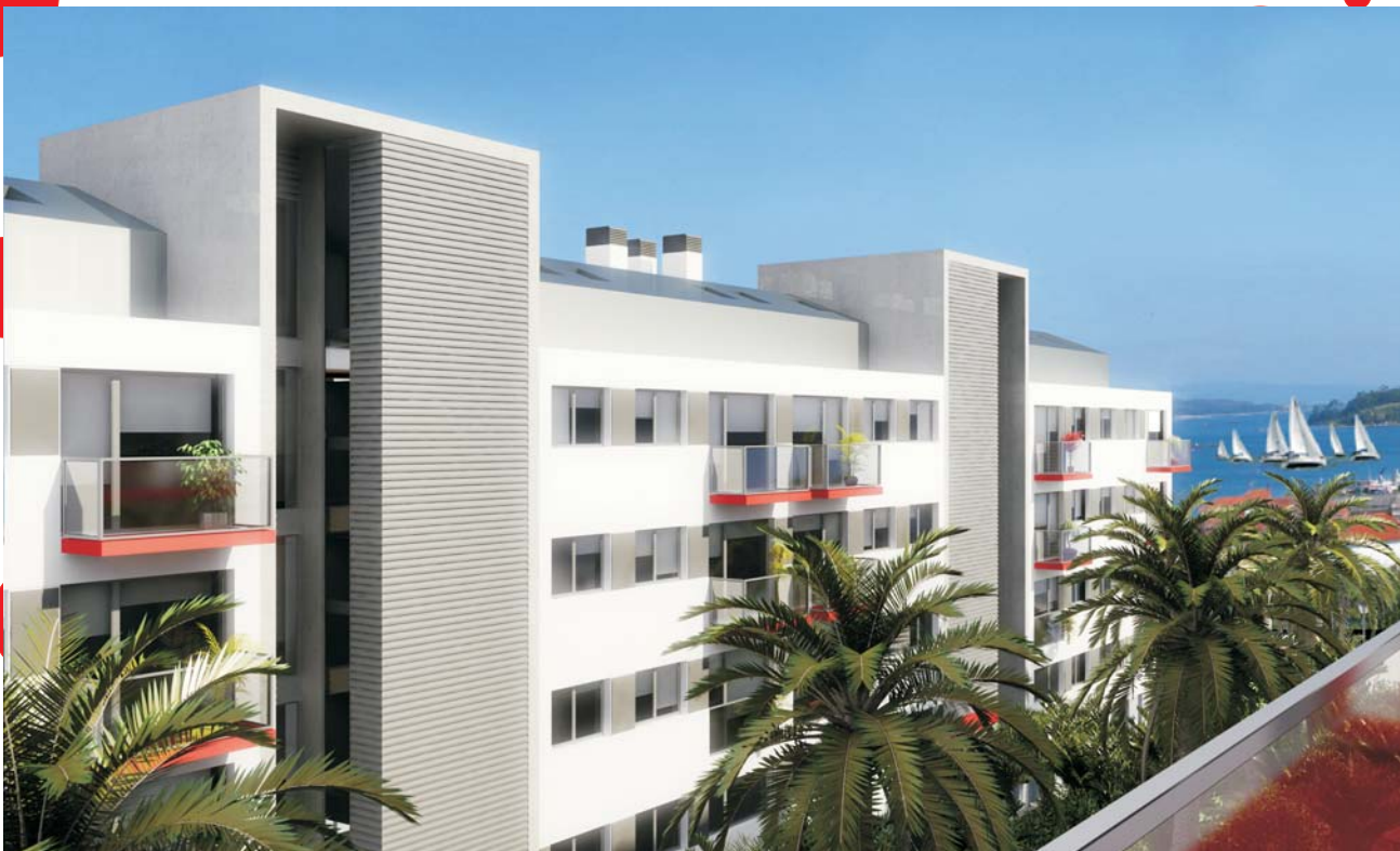
Edificio de viviendas en Puebla del Caramiñal
